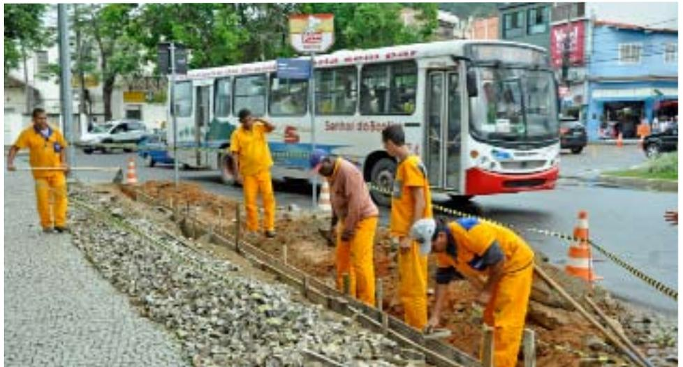
sem ter que manobrar. A parte retirada da calçada será substituída por piso de paralelos, material que é mais resistente que o asfalto ao peso dos ônibus estacionados.
